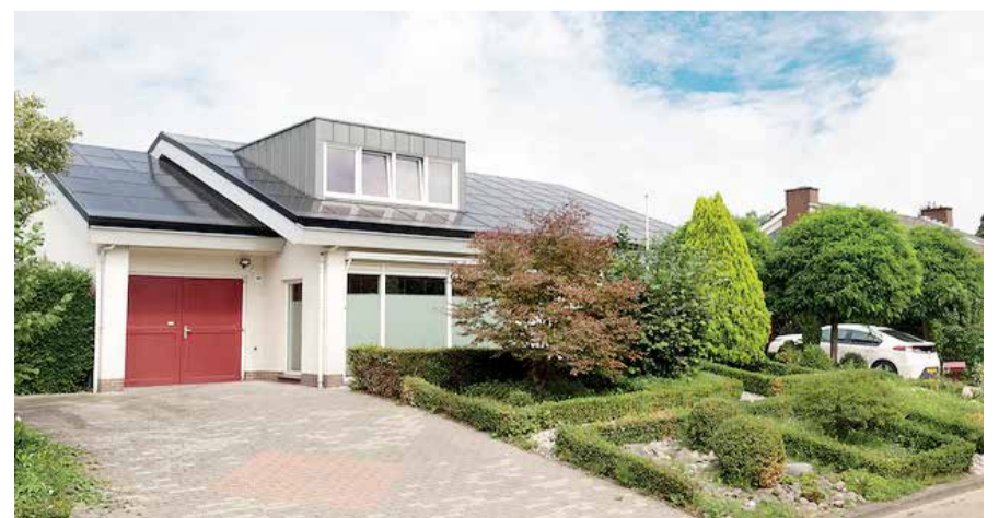
Als bij een dakrenovatie het dak moet worden vervangen, is een dakvullende en -geïntegreerde pv-oplossing goed mogelijk. Foto: BEAUSolar
