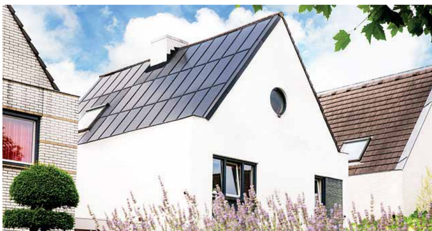
Als bij een dakrenovatie het dak moet worden vervangen, is een dakvullende en -geïntegreerde pv-oplossing goed mogelijk. Foto: BEAUSolar
